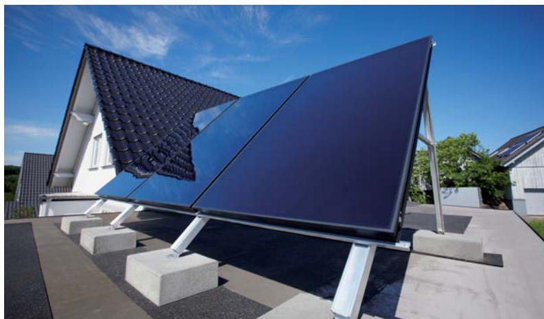
Praktické riešenie – solárne kolektory typu drain-back.
