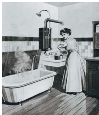
Plynový závesný ohrievač vody z roku 1905
